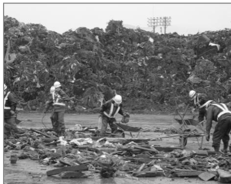
がれきの選別は重機に始まり最終的には手作業で行っています。
